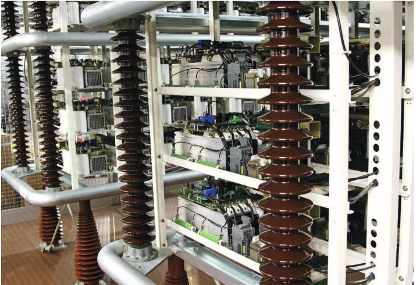
Schaltstufenracks der Hochspannungs-Gleichstrom-Versorgungsanlage
