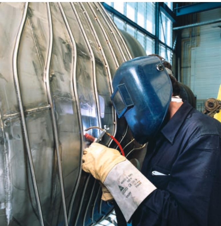
Schweißarbeiten am Plasmagefäß von Wendelstein 7-X
