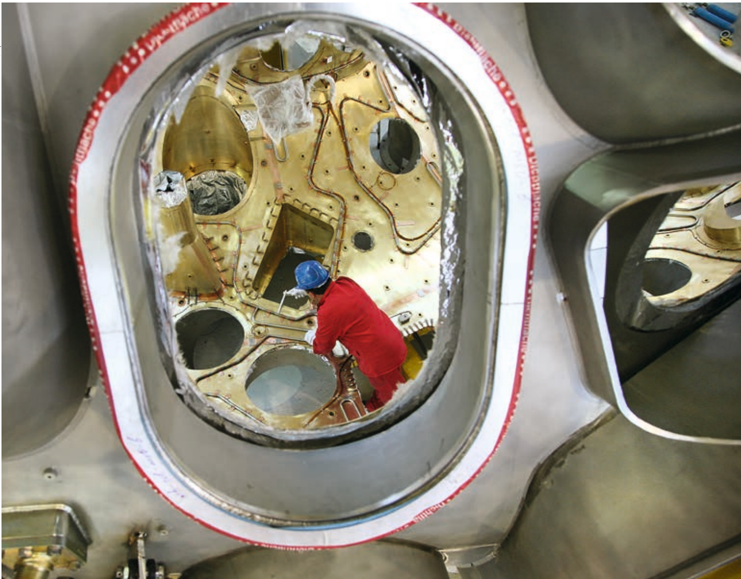
Montage der thermischen Isolation des Außengefäßes von Wendelstein 7-X
